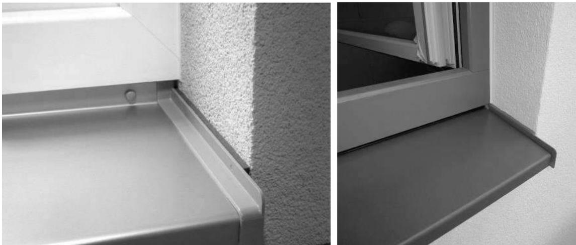
**Abbildung 25:** nachträgliche Fensterbankmontage - seitlicher Abschluss mit vorkomprimiertem Fugendichtband (BG1)
