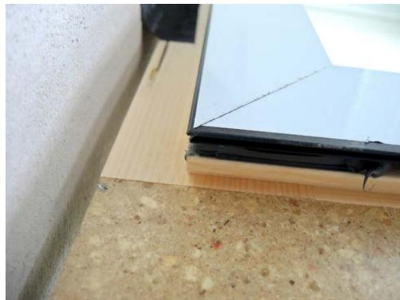
Abbildung 12b) Flächenbündiger Anschluss der Abdichtung
