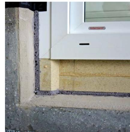
Abbildung 13b) Bodeneinstandsprofil mit Andichtkeil und Flüssigabdichtung
